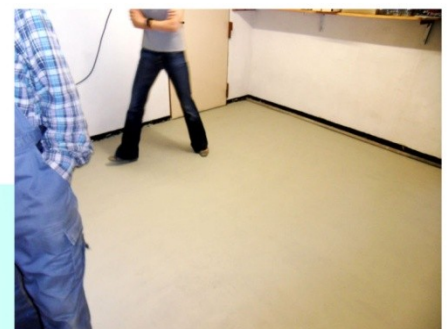
Nachträglicher begehbare Abschirmanstrich im Keller.
